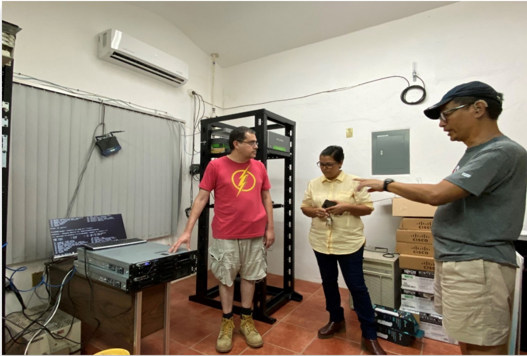
Instalación del nuevo servidor PFSense que administra la red de la Estación Chamela
