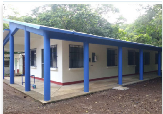
Obra terminada instalación nueva para personal administrativo para pernoctar, 2022
